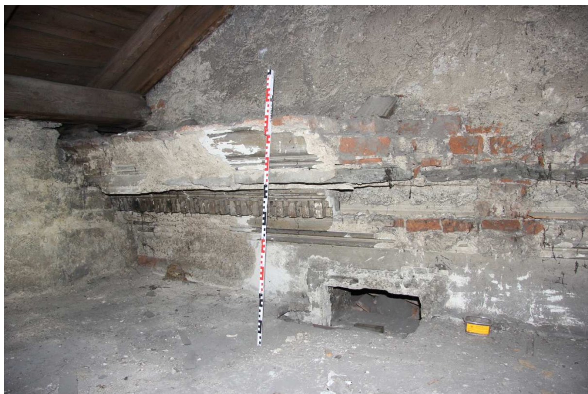
Torzo původní korunní římsy a původní okénko půdní nadezdívky budovy č.p. 17 dochované u jižního průčelí východního křídla (dnes skryté v podkroví č.p. 404)
