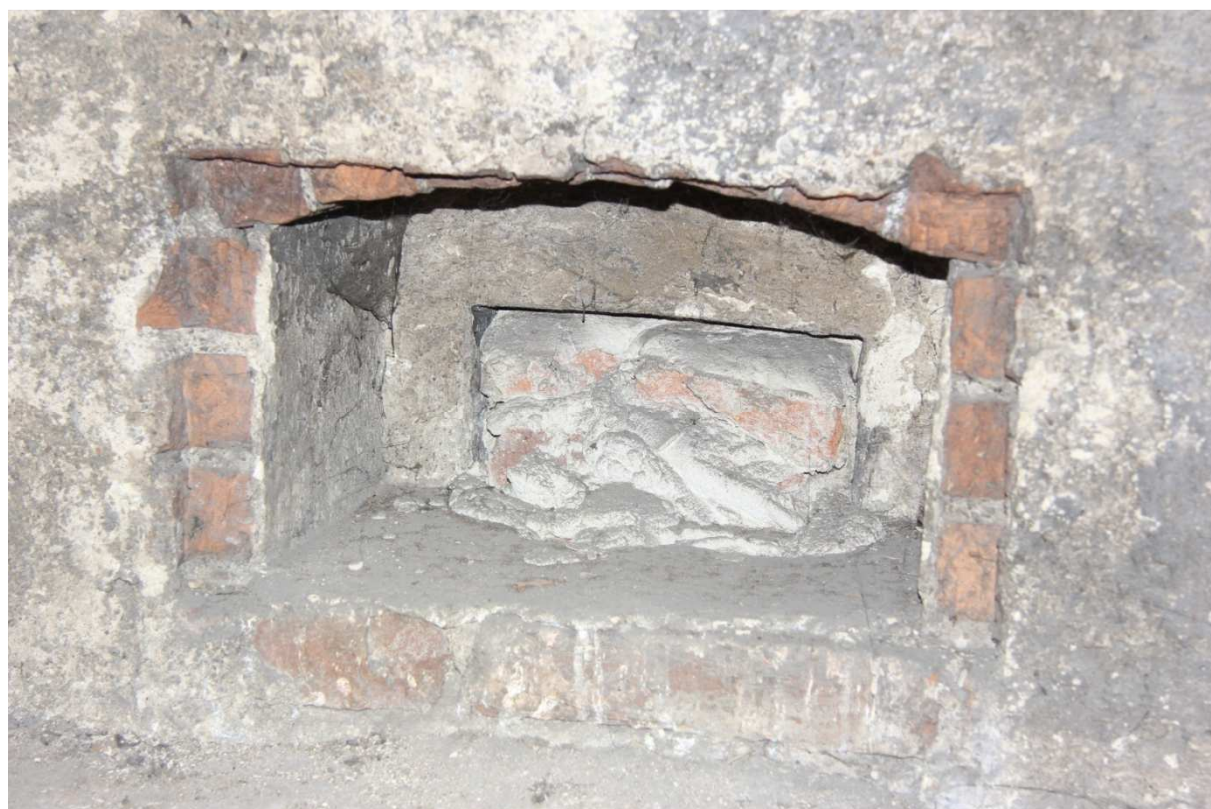
Č.p. 404_podkroví_Půdní nadezdívka jižně od schodišťového rizalitu se zazděnými původními okénky. Detail jižního z nich
