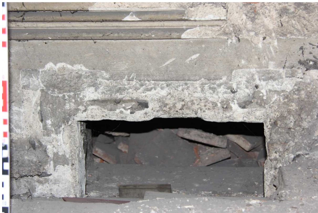
Původní okénko půdní nadezdívky budovy č.p. 17 dochované u jižního průčelí východního křídla (dnes skryté v podkroví č.p. 404) se znatelným otiskem odstraněné šambrány s uchy
