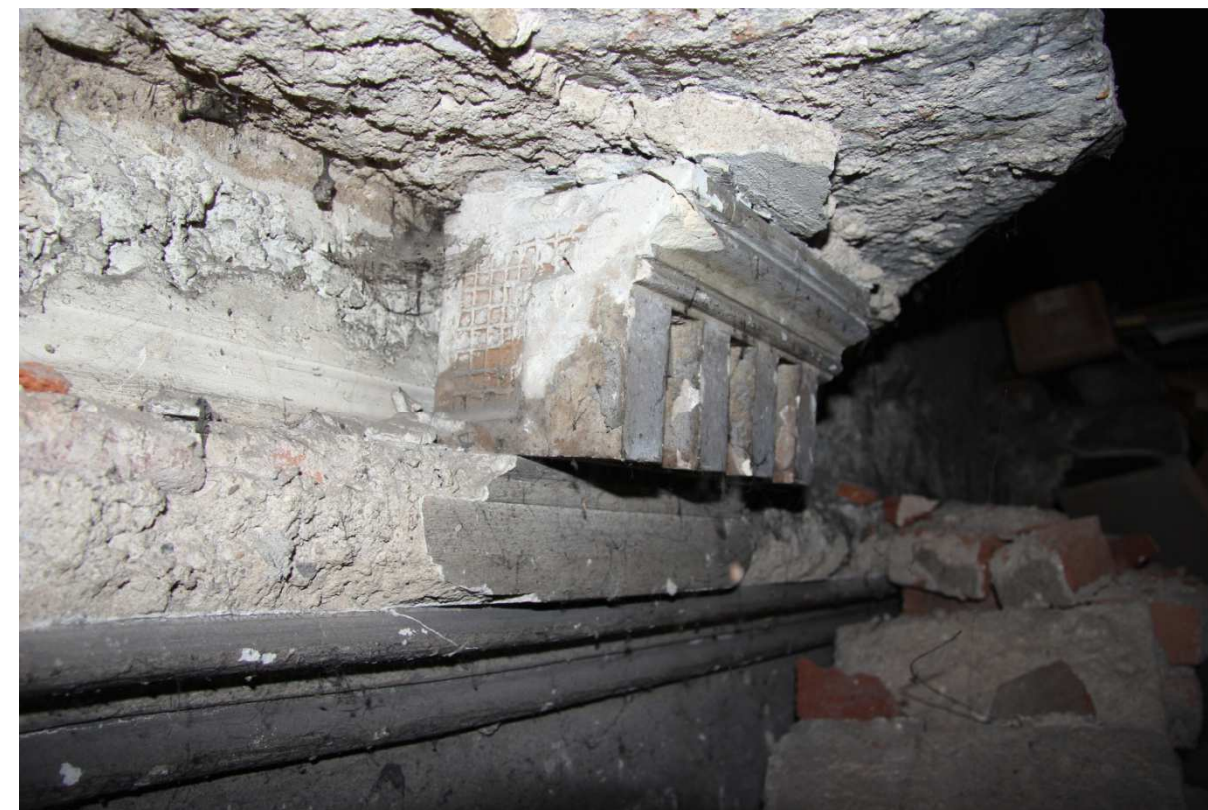
Torzo původní korunní římsy budovy č.p. 17 dochované u jižního průčelí východního křídla (dnes skryté v podkroví č.p. 404). Zuborez je složen z prefabrikovaných částí
