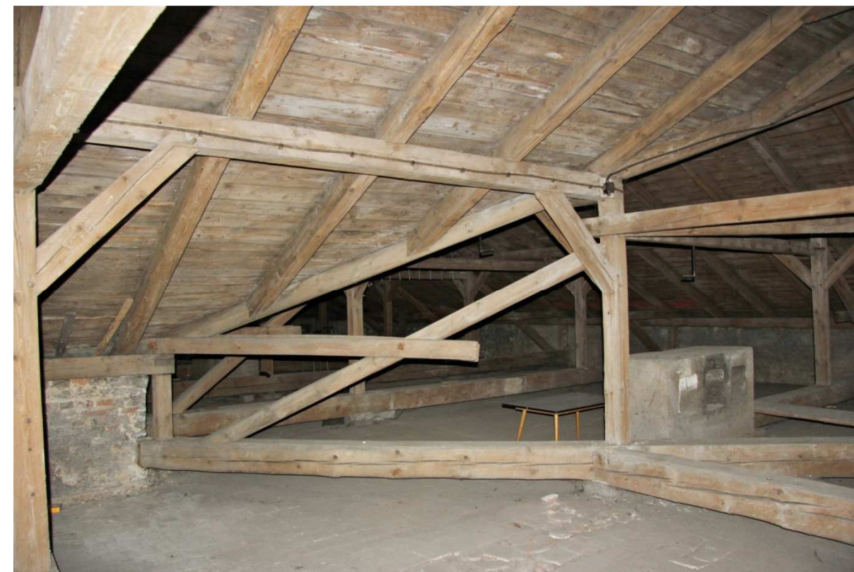
Č.p. 404_podkroví_Detail krovu v místě úžlabí mezi jižním a východním křídlem
