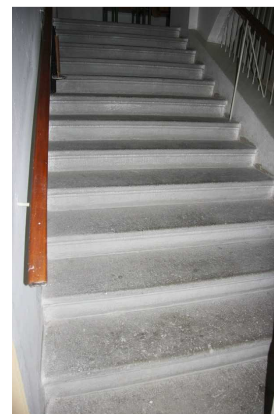
Č.p. 404_2. patro_Schodiště do podkroví_Pohledy k západu na spodní rameno schodiště s původními kamennými stupni
