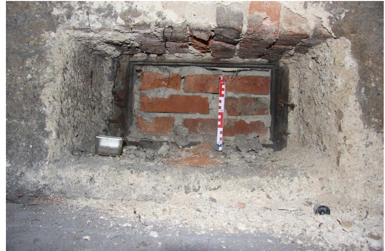
Č.p. 17_podkroví_Detail jednoho z okének půdní nadezdívky, vč. původního rámu okna
