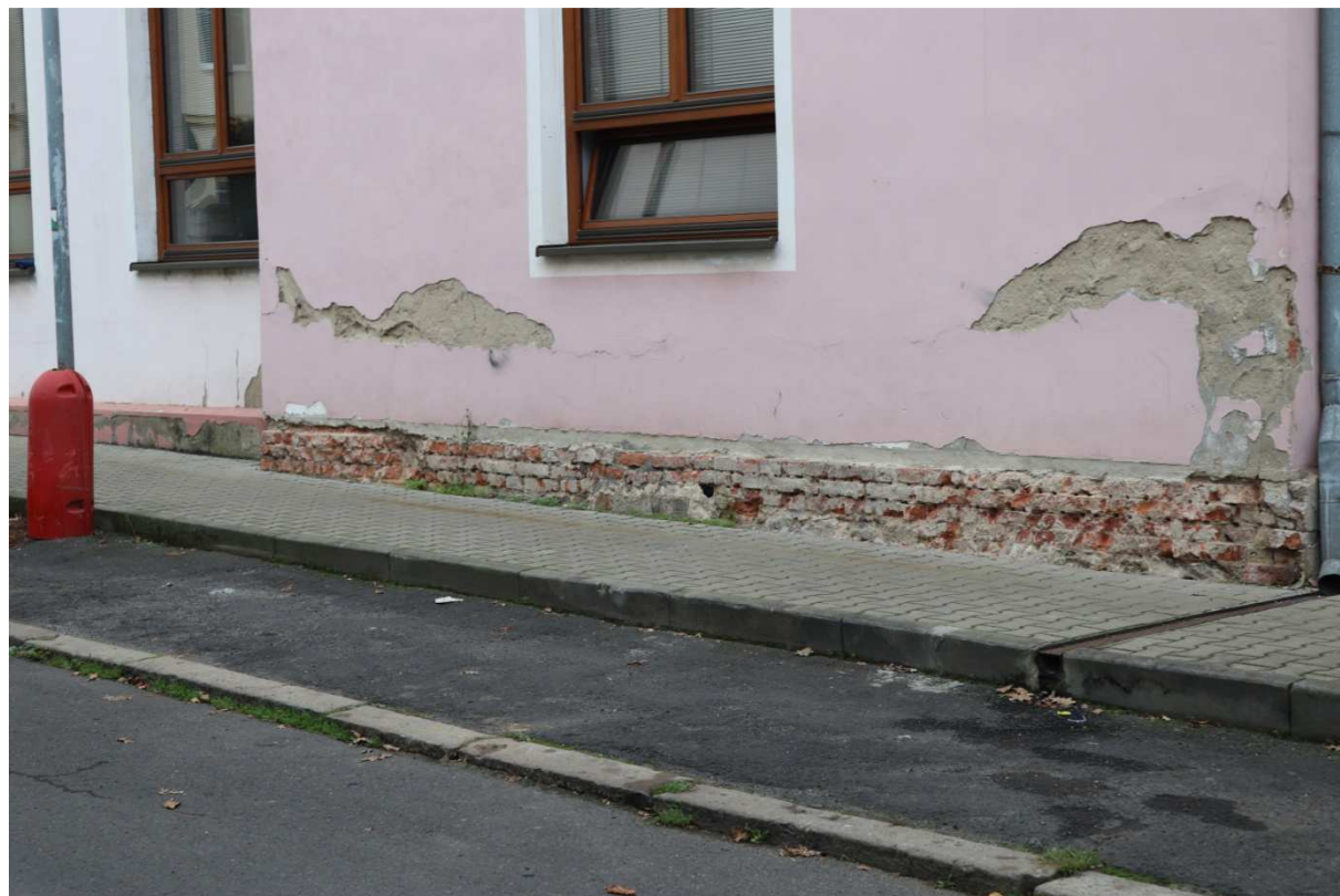
Východní průčelí č.p. 404. Detail cihelného zdiva soklu v místě rizalitu
