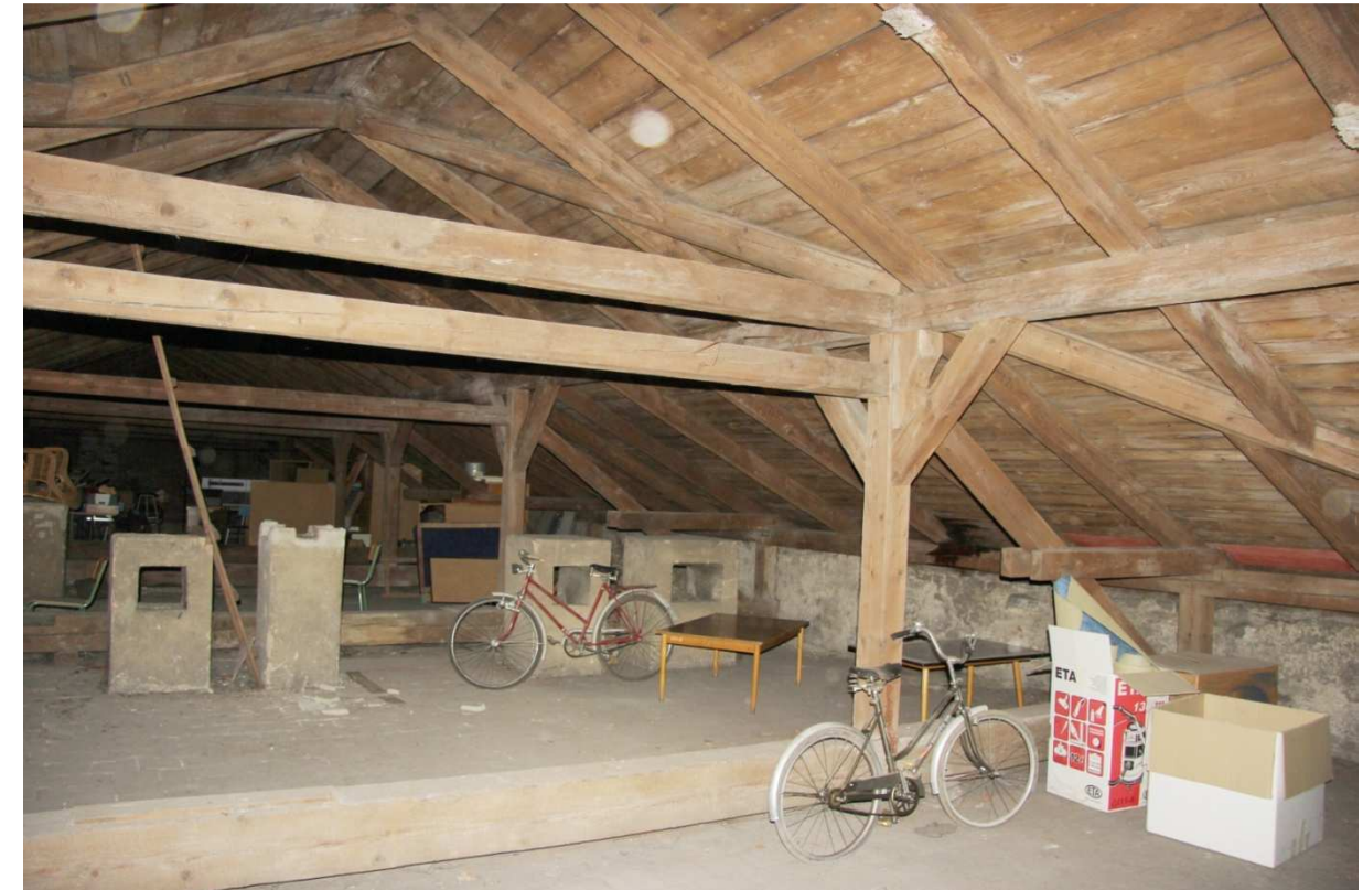
Č.p. 404_podkroví_Východní křídlo. Pohled k severu na rozhraní krovu nad starší a mladší částí. Na snímku je dobře patrná diagonální nárožní krokev původní jižní valby zakončující na jihu starší část
