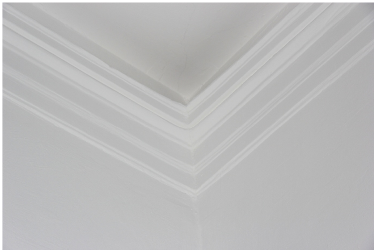
Č.p. 17_2. patro_Chodba 3.08_Detail původní podstropní římsy
