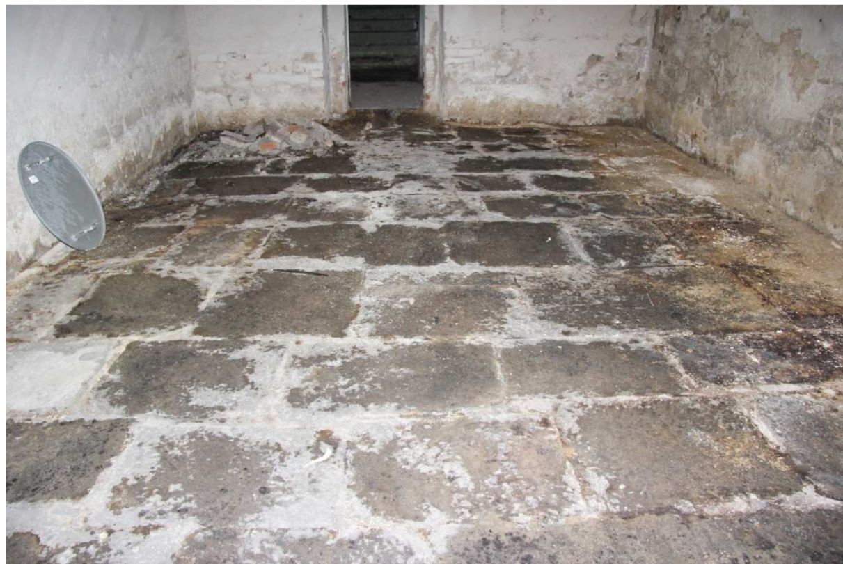
Č.p. 17_suterén_Sklep 0.03_Detail původní kamenné dlažby
