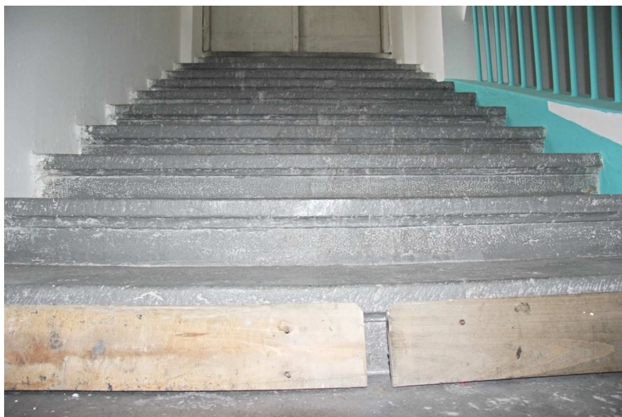
Č.p. 17_2. patro_Schodiště do podkroví_Detail původních kamenných stupňů spodního ramene
