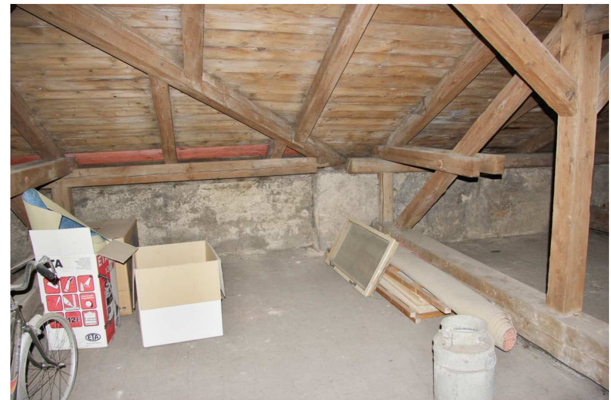
Č.p. 404_podkroví_Východní křídlo. Detail paty původní diagonální nárožní krokve jižní valby starší části (viz snímek nahoře)
