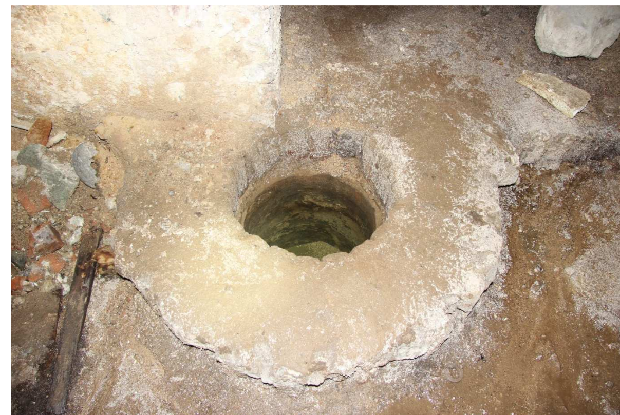
Č.p. 404_suterén_Chodba 0.06 (jižní část)_Pohled na jižní z dvojice vodních jímek v 0.06 (na rozhraní s 0.09)
