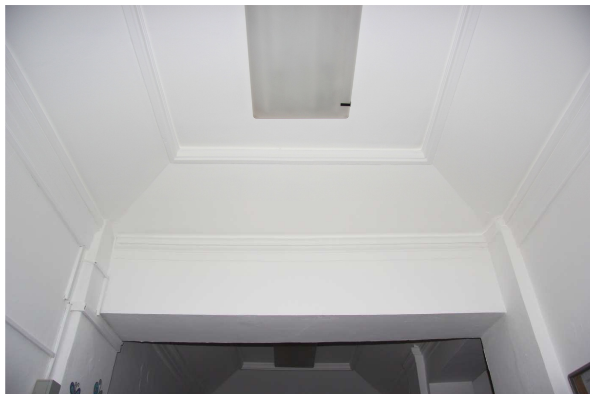
Č.p. 17_1. patro_Chodba 2.08_Detail původní zrcadlové klenby
