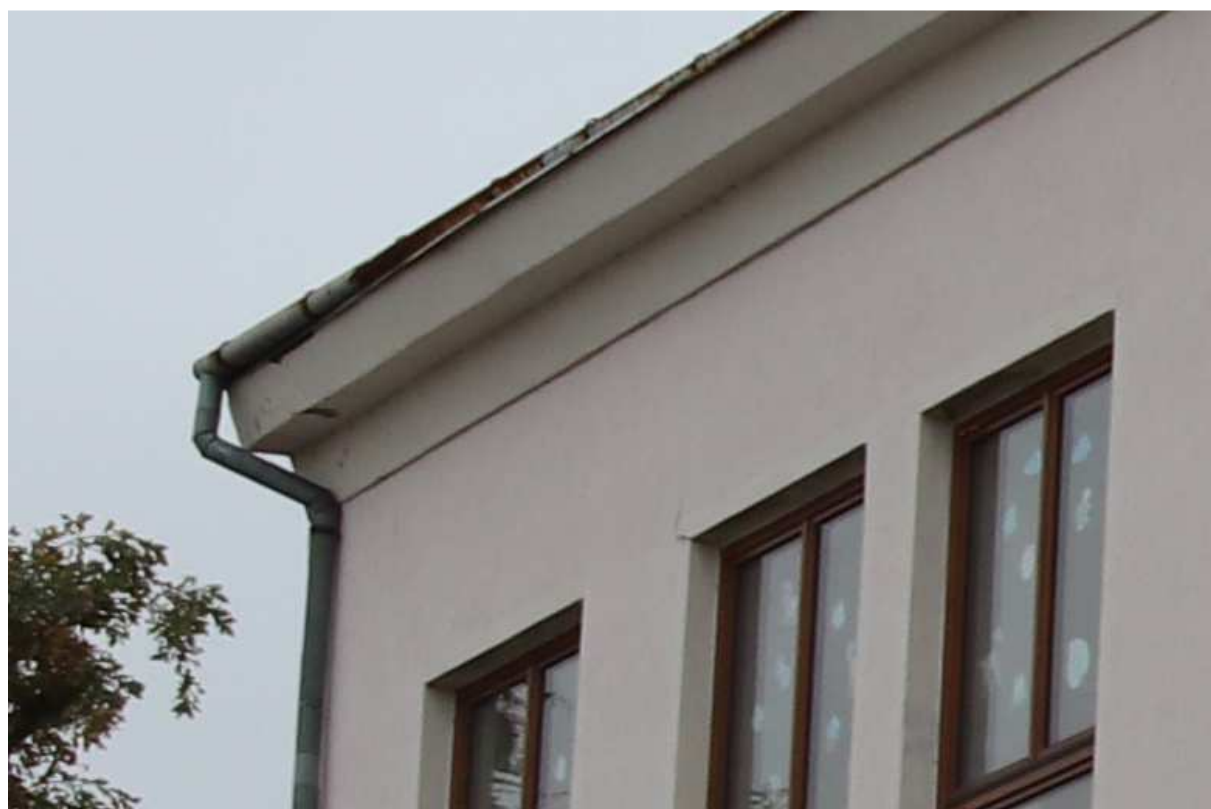
Jižní průčelí budovy č.p. 404. Stávající stav korunní římsy
