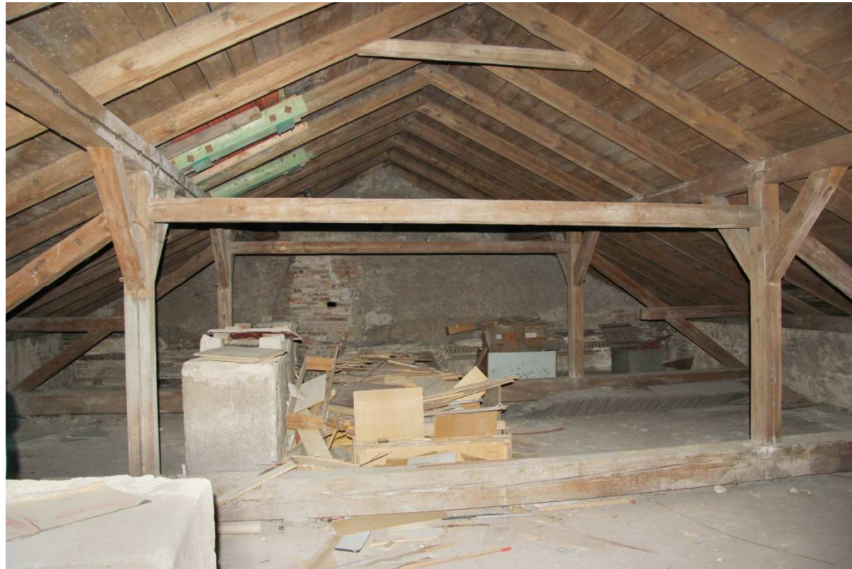
Č.p. 404_podkroví_Východní křídlo. Krov nad starší severní částí při pohledu k severu. V pozadí zděný protipožární štít oddělující budovu č.p. 17
