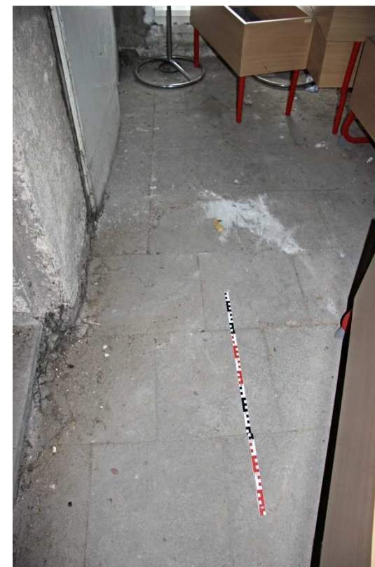
Č.p. 17_podkroví_Schodiště do podkroví_Vlevo původní kamenná dlažba mezipodesty schodiště. Vpravo pohled na horní rameno schodiště
