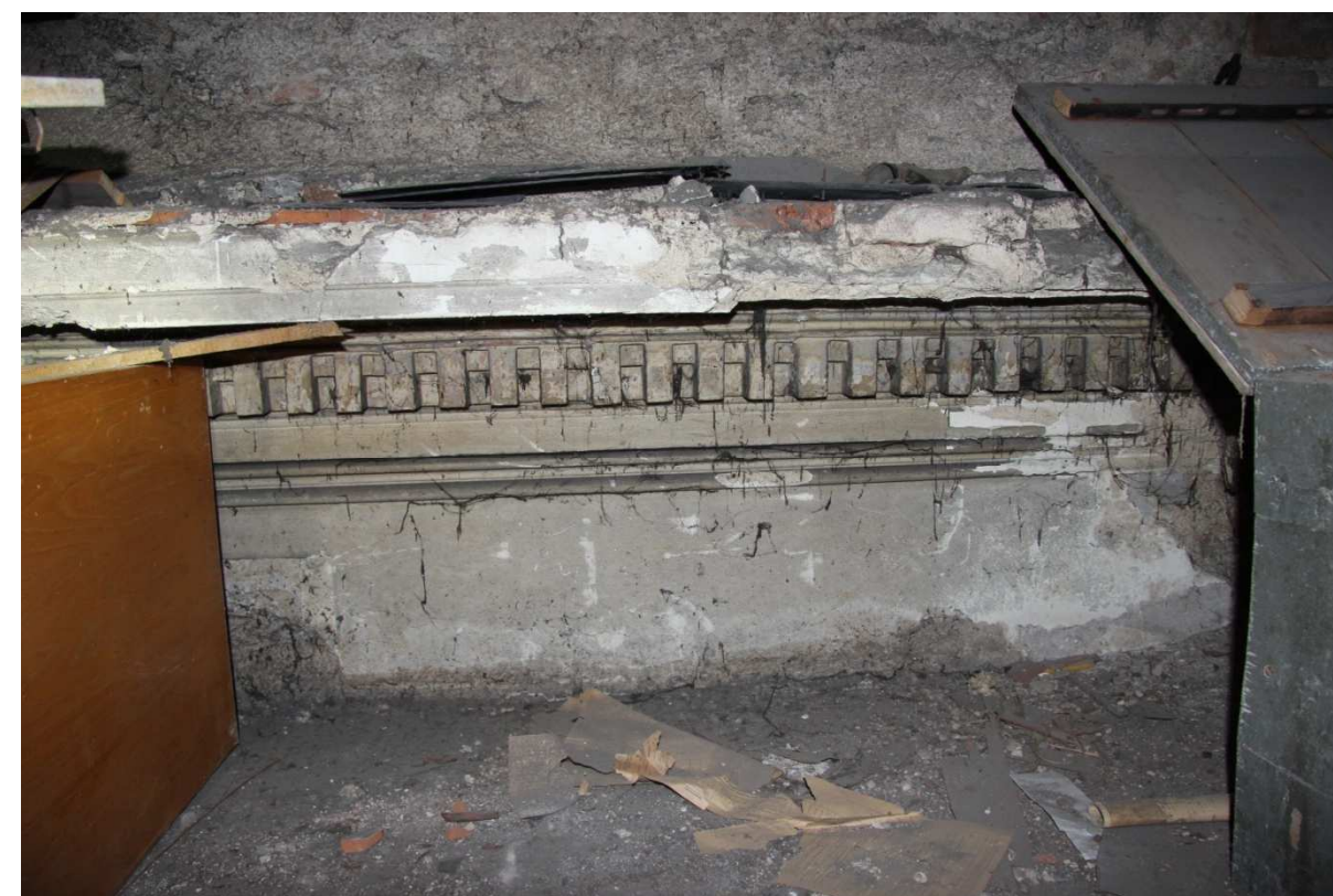
Torzo původní korunní římsy budovy č.p. 17 dochované u jižního průčelí východního křídla (dnes skryté v podkroví č.p. 404)
