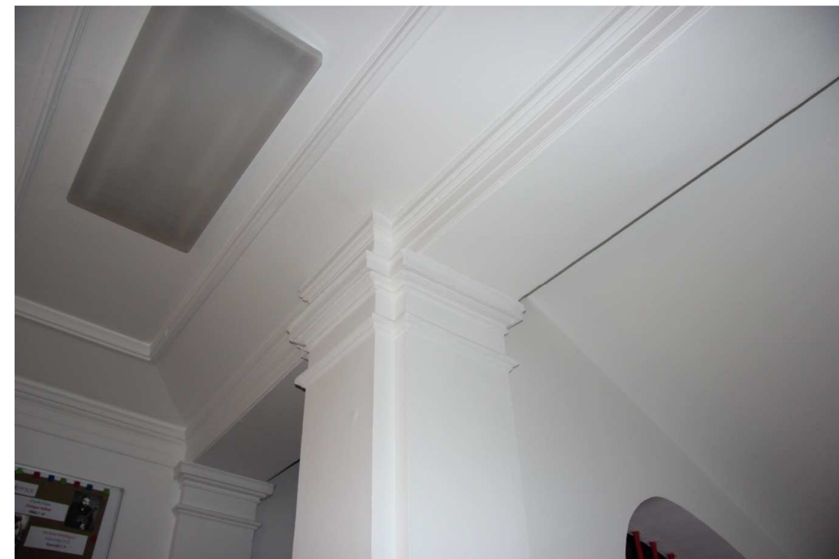
Č.p. 17_přízemí_Schodiště do 1. patra_Detail původní zrcadlové klenby mezipodesty 2.01
