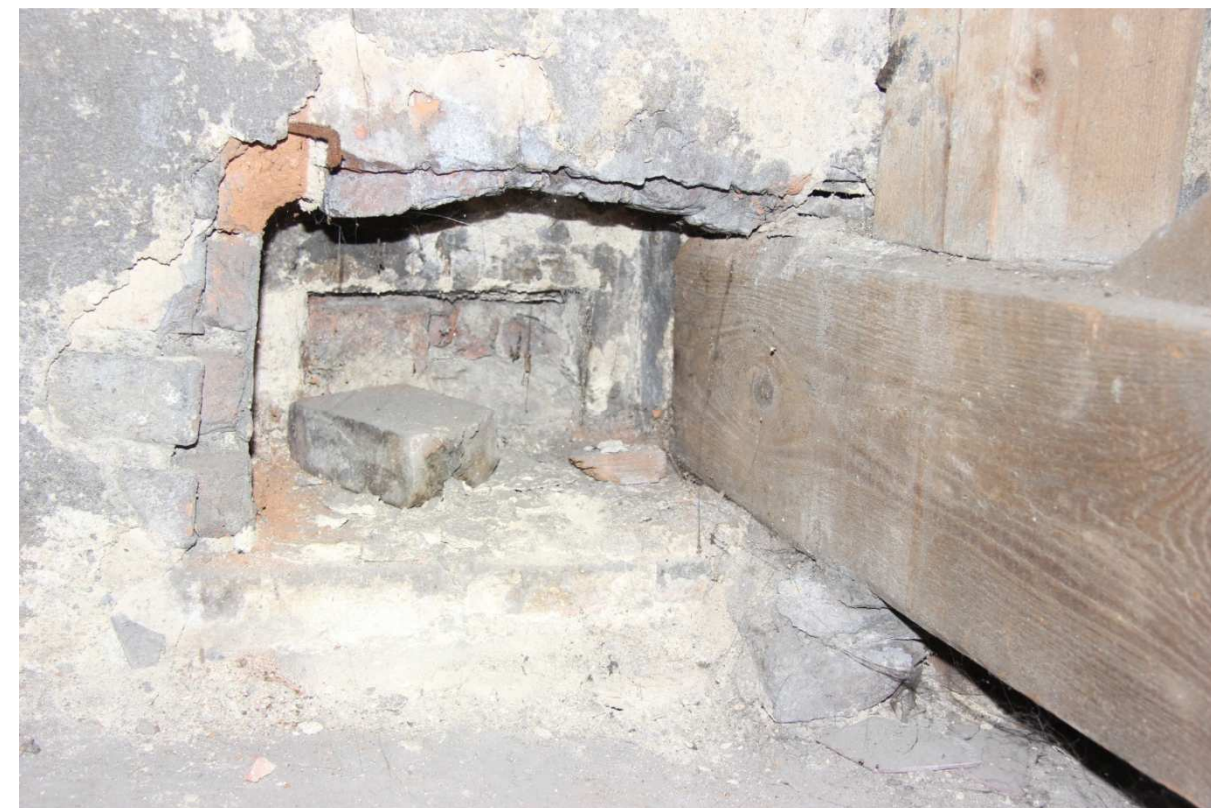
Č.p. 404_podkroví_Půdní nadezdívka jižně od schodišťového rizalitu se zazděnými původními okénky. Detail severního z nich
