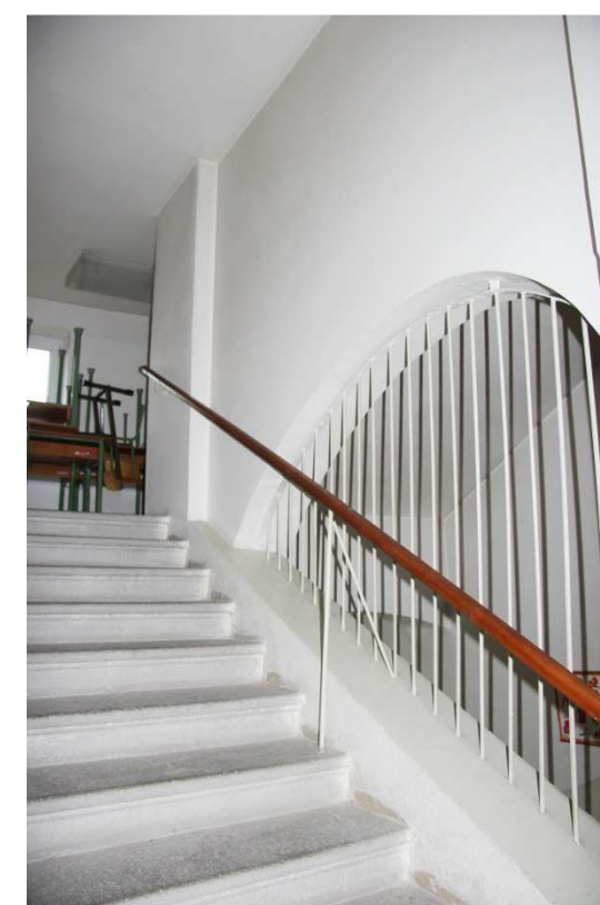
Č.p. 404_2. patro_Schodiště do podkroví_Pohledy k západu na spodní rameno schodiště s původními kamennými stupni
