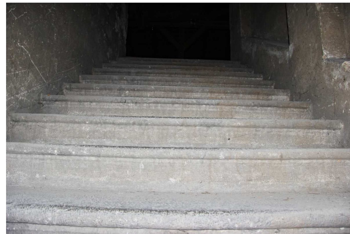
Č.p. 404_podkroví_Horní rameno schodiště z 2. patra. Detail původních kamenných schodů
