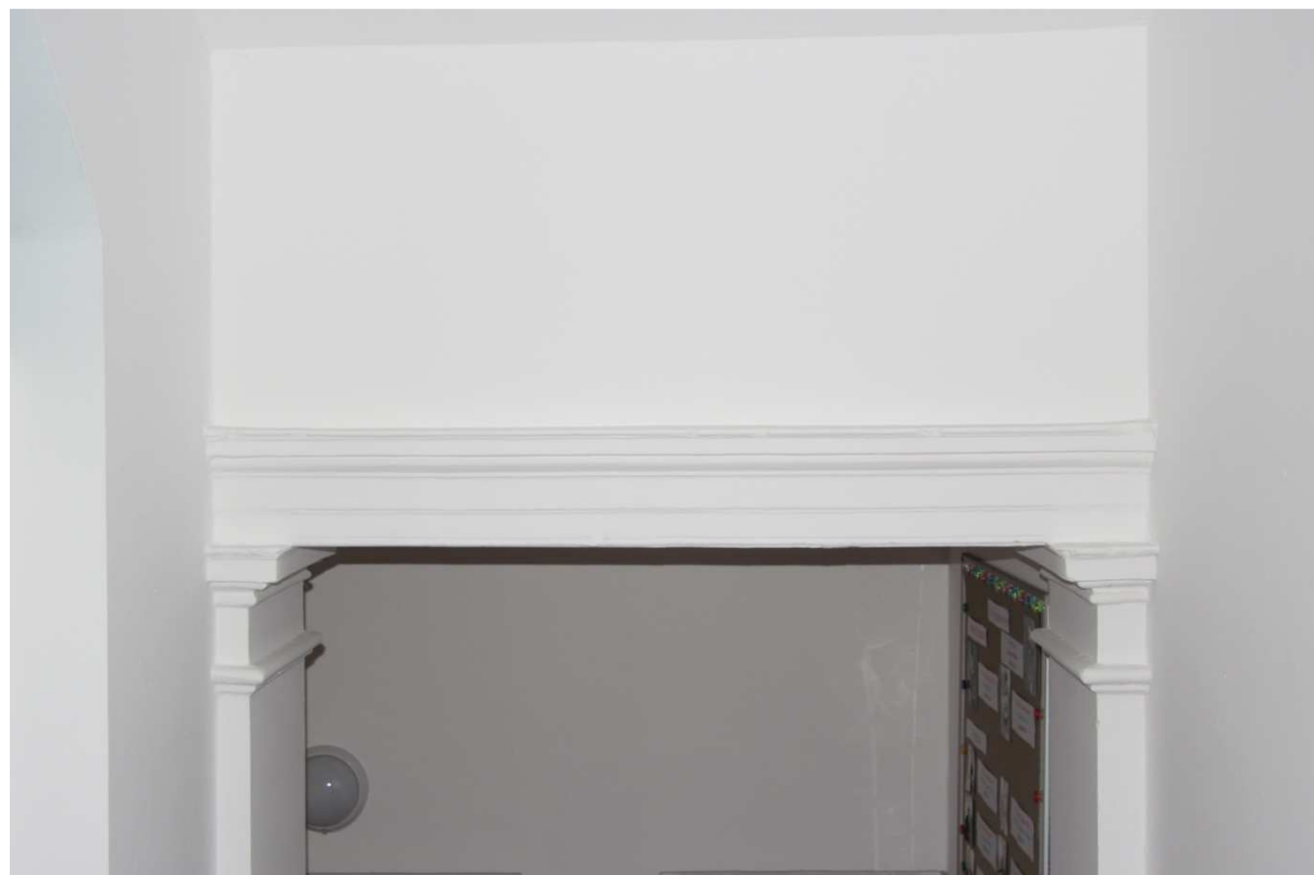
Č.p. 17_přízemí_Schodiště do 1. patra_Detail původního překladu nad nástupem na horní rameno z mezipodesty 2.01
