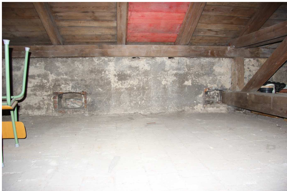
Č.p. 404_podkroví_Půdní nadezdívka jižně od schodišťového rizalitu se zazděnými původními okénky
