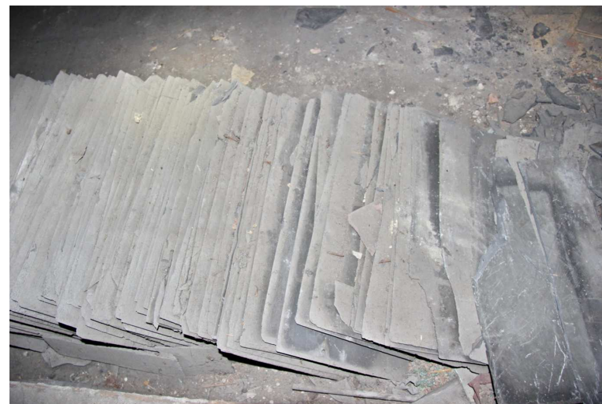
Č.p. 404_podkroví_V podkroví deponované původní břidlicové plotny, kterými byly střechy školy pokryty
