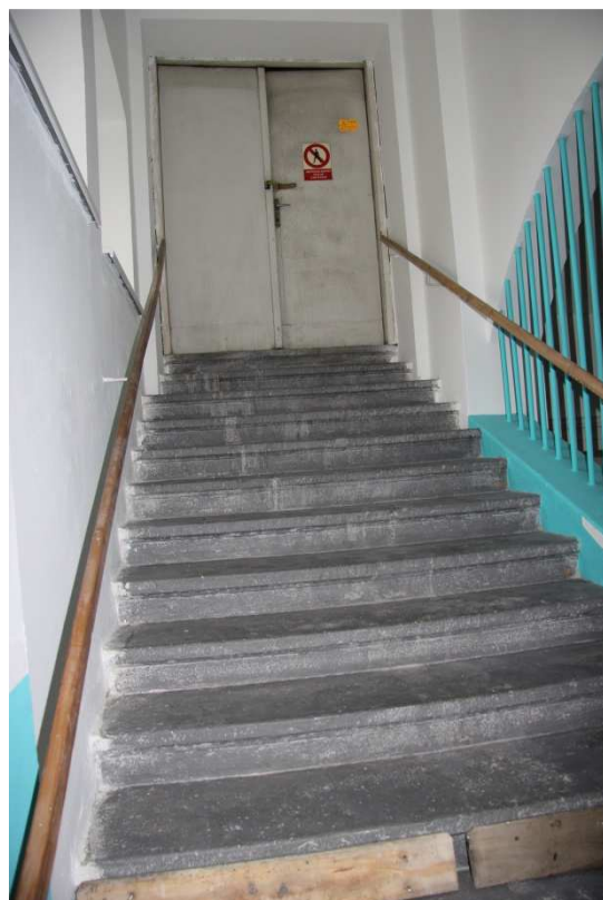
Č.p. 17_2. patro_Schodiště do podkroví_Pohledy na spodní rameno schodiště s původními kamennými stupni
